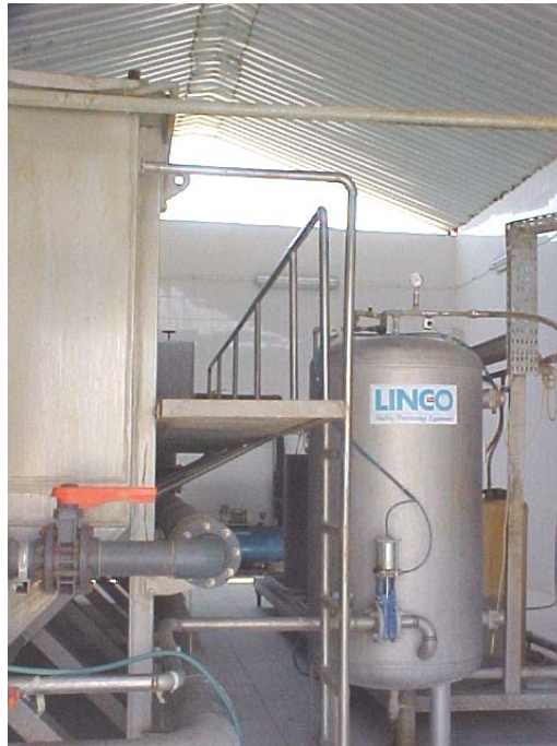
شكل (45) أجهزة تنقية مياه الصرف للمسالخ بواسطة الإضافات الكيميائية
